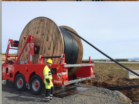
Jarðvinna og lagning
