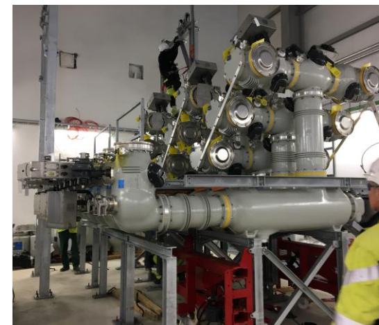
Tengivirki Rafbúnaður og uppsetning
